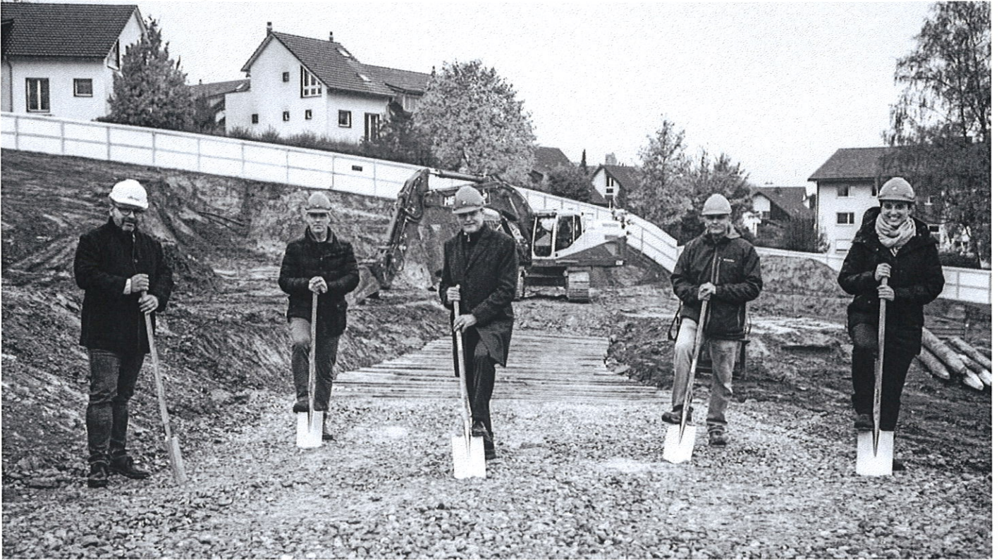
Gemeindepräsident Jörg Kündig (Mitte) setzt zum Spatenstich an. Damit wird auch die letzte Parzelle im Eich bebaut. Foto: Seraina Boner
