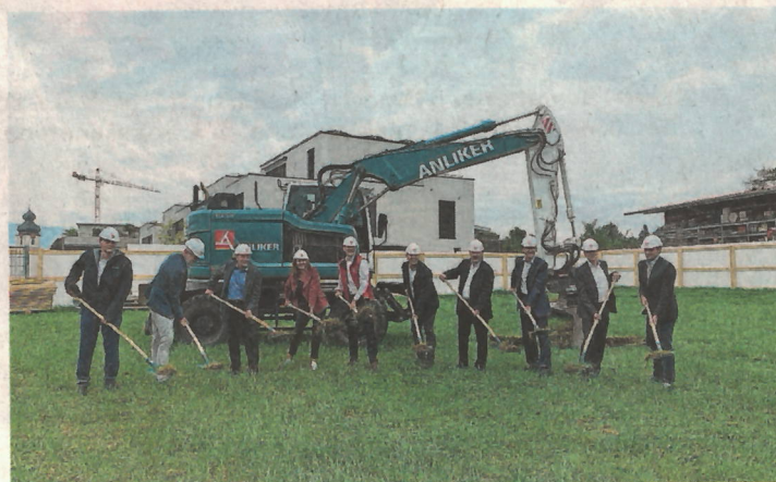
Der Spatenstich für die Solea-Überbauung wird vollzogen. Bild: zvg
